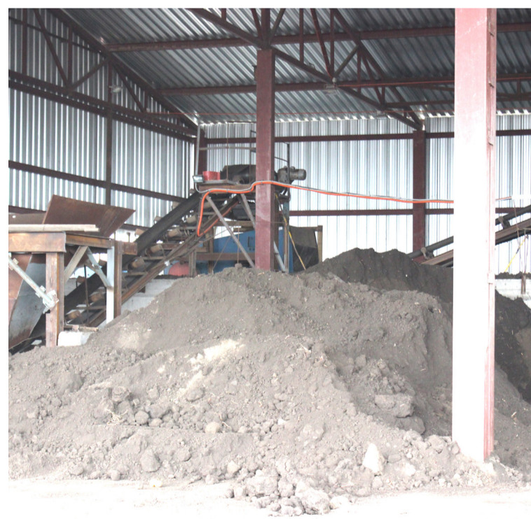
оборудование для просева и фасовки земли
